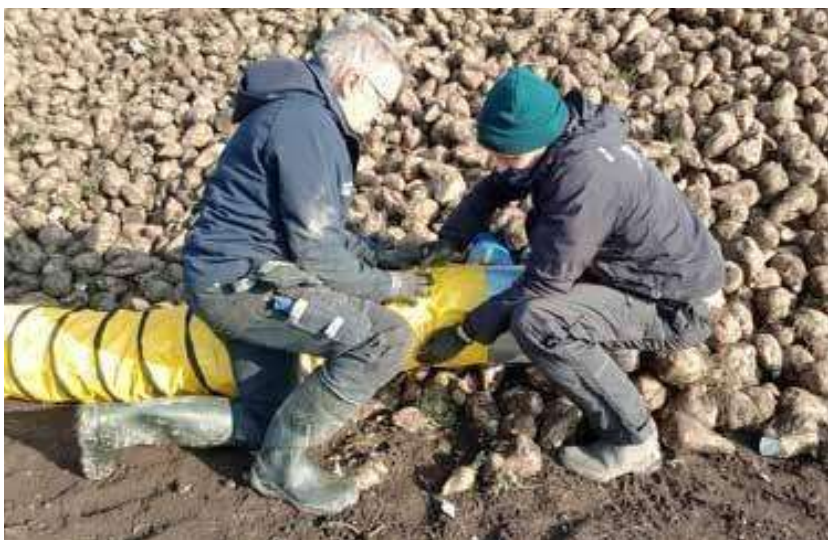
Koppla ihop. Montering av spiralslang mellan ventilationsrören.
